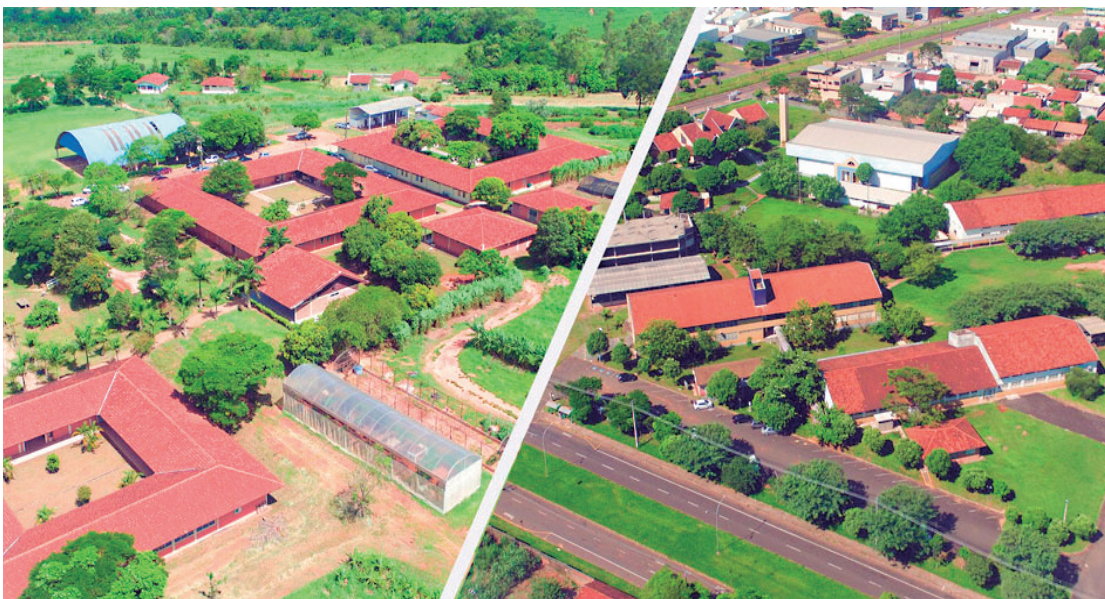
Unidade fazenda UEM mantém uma grande estrutura em Umuarama
