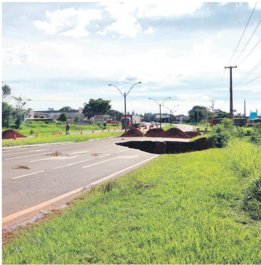
O desmoronamento ocorreu no sábado, após um bueiro estourar e levar parte da pista junto
