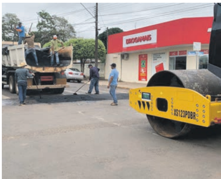
Prefeita Milena acompanha o andamento das obras
