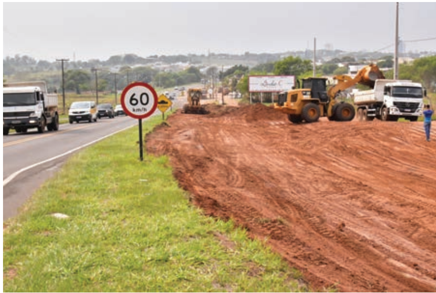
Os trabalhos de duplicação da avenida já foram iniciados
