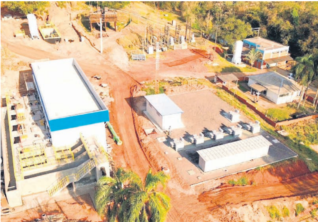
Obras de ampliação do abastecimento de Umuarama aumentam em mais de 50% a capacidade do sistema
