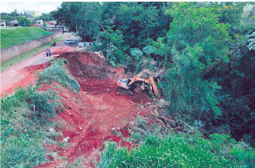
**OBRA NO PARQUE INDUSTRIAL-** A Prefeitura de Umuarama iniciou a recuperação de um foco de erosão que se formou nos últimos meses na Avenida Industrial, uma das principais vias de acesso ao bairro Parque Industrial. Após o rompimento de um dissipador, dois ramais de galerias foram danificados. Página A3
