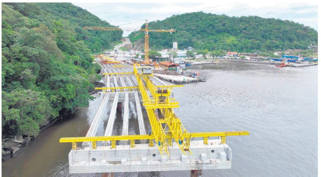
PONTE DE GUARATUBA JÁ GANHA FORMA - A Ponte de Guaratuba começa a ganhar forma com a instalação das vigas longarinas de concreto pré-moldadas. Essas estruturas compõem a base da futura ponte e dão cara ao traçado que ligará os municípios de Guaratuba e Matinhos. Neste mês de janeiro, as obras da ponte alcançaram 35,3% de execução. Página A5
